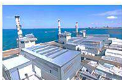
▲ 五井火力発電所
